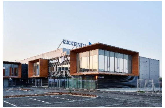
Fotol: Pakendikeskuse logistikakeskus (teostaja Nordecon Betoon OÜ)
